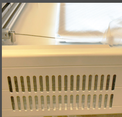
Ouies de ventilation
